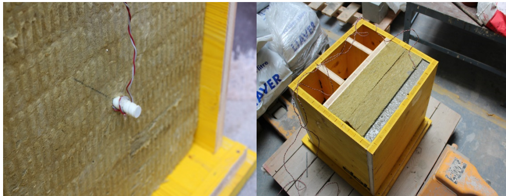
Abb. 62: links: Temperatursensor am Verbindungsmittel, rechts: fertige Betonage Außenschale
